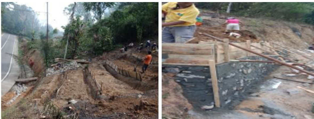
Gambar 2: Penerapan geopolimer pada lereng yang rawan longsor.
