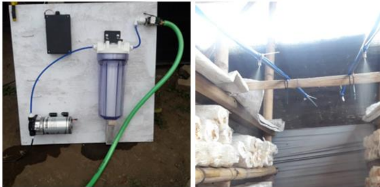
Gambar 5. Proses Pemasangan Alat dan Uji Coba Alat Pada Kumbung Jamur Foto: Dokumentasi Pribadi Diah Risqiwati
